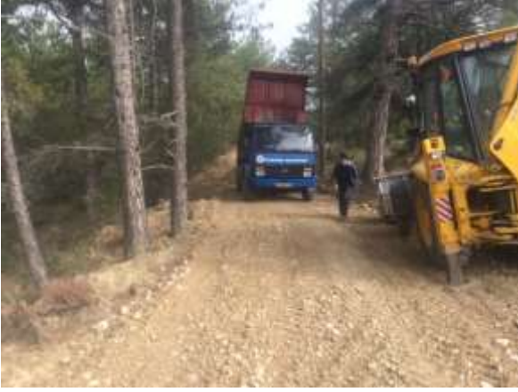
26. TOKİ Su deposu yolu çakılama yapılması
